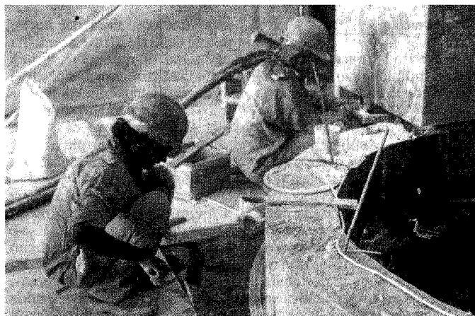
OPERAI AL LAVORO PER LO STADIO DI DOHA FOTO REUTERS
