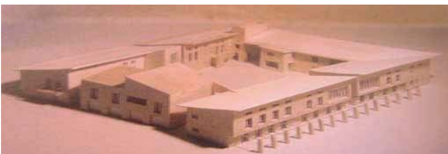
Torri di ventilazione, logge solari, involucri efficienti e serramenti ad elevate prestazioni
