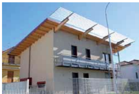
Brembate Sopra. Casa del Sole. Struttura mista calcestruzzo-S/R (Vanoncini) Bergamo/Lombardia/2009
