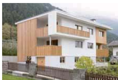
Edificio plurifamiliare a Oris, Bolzano/Trentino Alto Adige/2011
