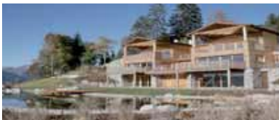
Edificio bifamiliare, Avelengo, Merano Trentino Alto Adige/2011 Sistema Soligno- Rubner Haus
