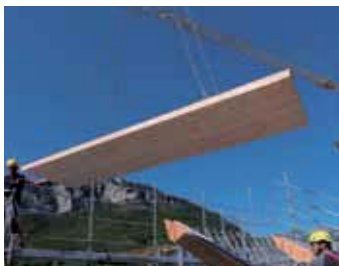
DAMIANI HOLZ & co. (LignoAlp) e BinderHolz Pannelli in legno massiccio a strati incrociati.
