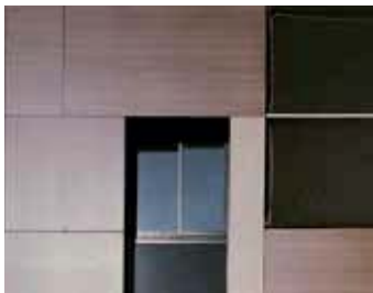
TRESPA Meteon pannello laminato in fibra di legno e carta riciclati
