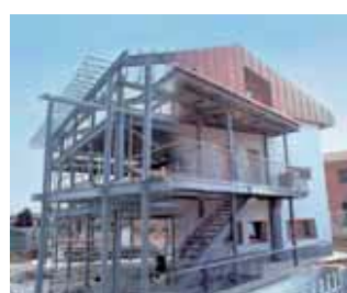
Passivhaus a Chignolo d'Isola Vanoncini spa
