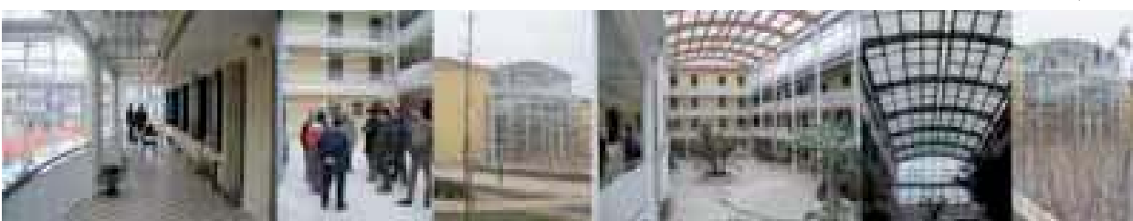
Riqualificazione quartiere Savonarola, Padova ANNO 2003 Serra bioclimatica come giardino d'inverno per appartamenti a ballatoio Fonte: www.centroabita.unifi.it
