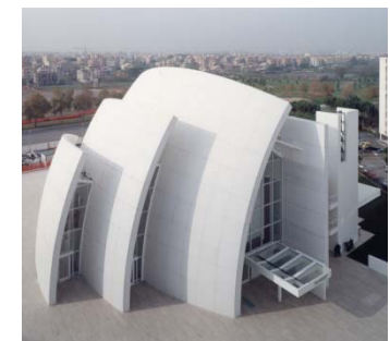
Tx Active® principio attivo fotocatalitico per materiali cementizi, brevettato da Italcementi.
