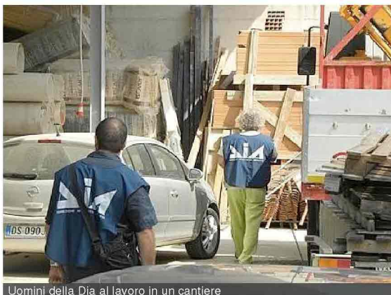
Uomini della Dia al lavoro in un cantiere
