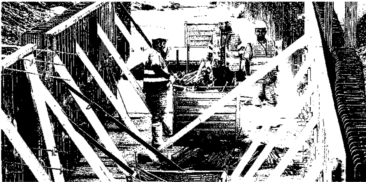
Il cantiere a Rho-Però. A sinistra: in alto Onorio Rosati della Cgil, in basso l'ad di Expo spa Giuseppe Sata
