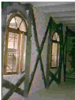
Applicazione di **rinforzi in FRP** (compositi fibrorinforzati a matrice polimerica) per strutture murali
