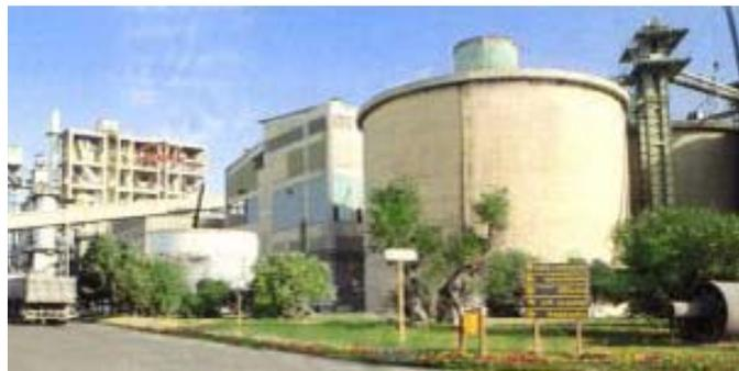
Impianto Cementir di Taranto, impiego di loppa d'altoforno per la produzione di cemento
