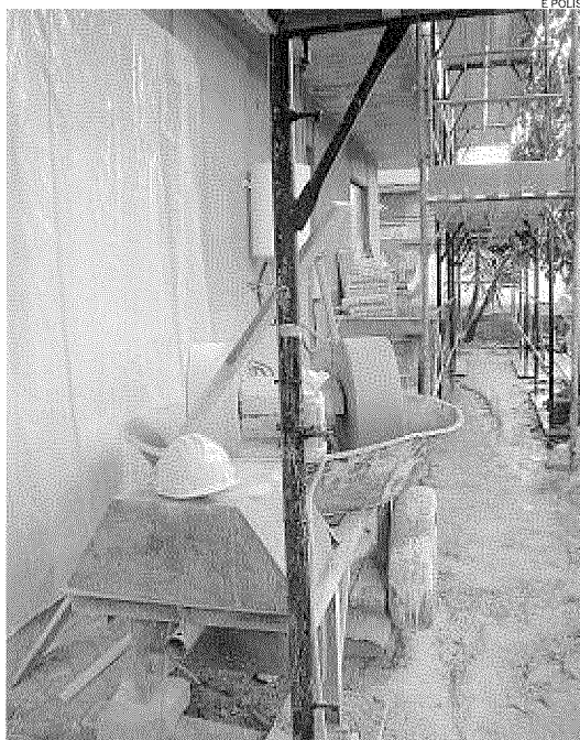
► Un cantiere in città
