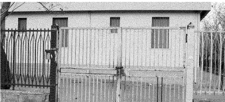
La scuola Musco posta sotto sequestro perché sono emerse evidenti lacune in ordine alla sicurezza statica
