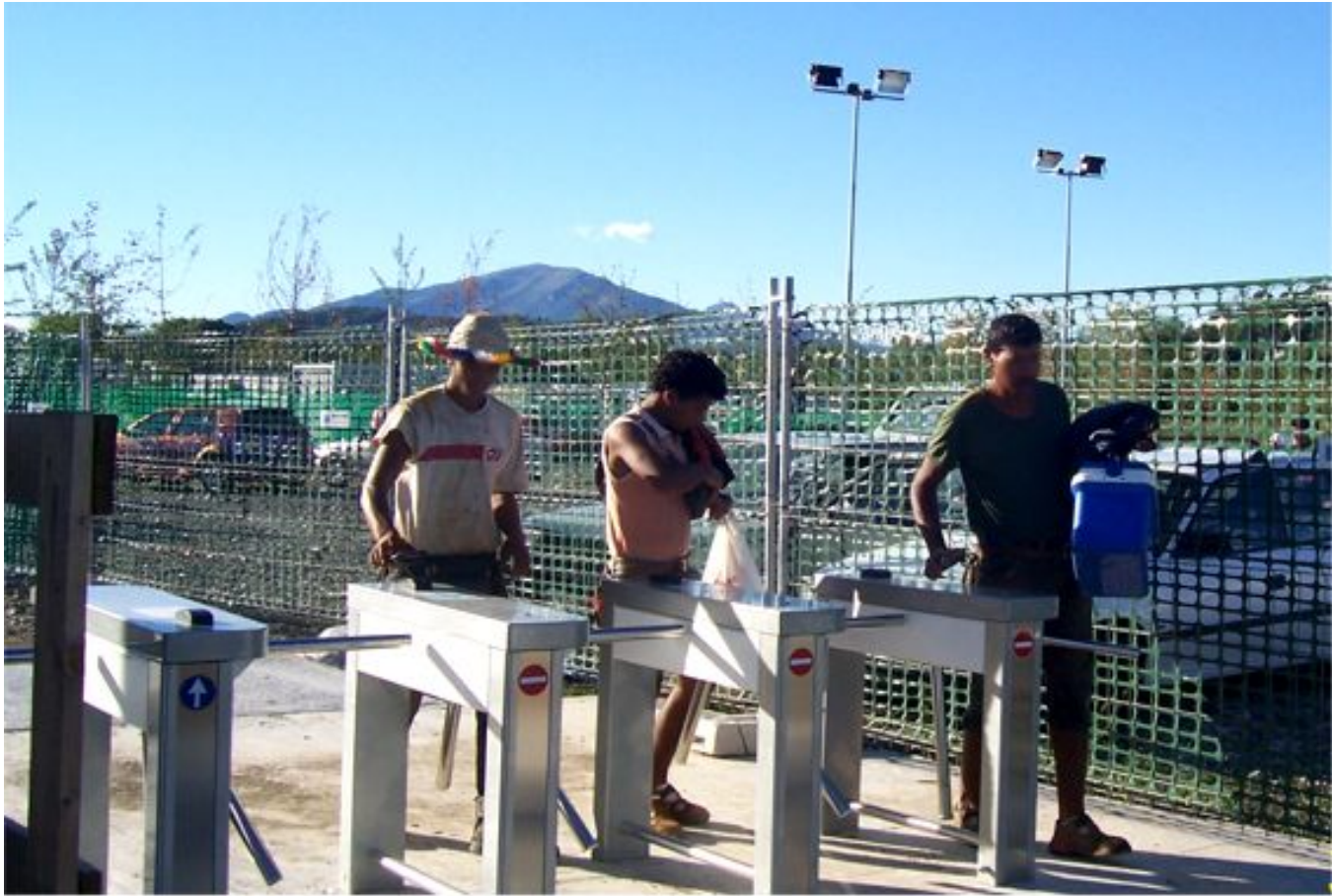
30/08/2006 Controllo accessi in cantiere
