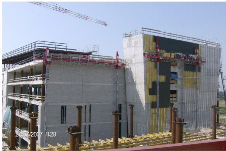
27/07/07 Torre 1 - Facciata del corpo scale sulla Hospital Street
