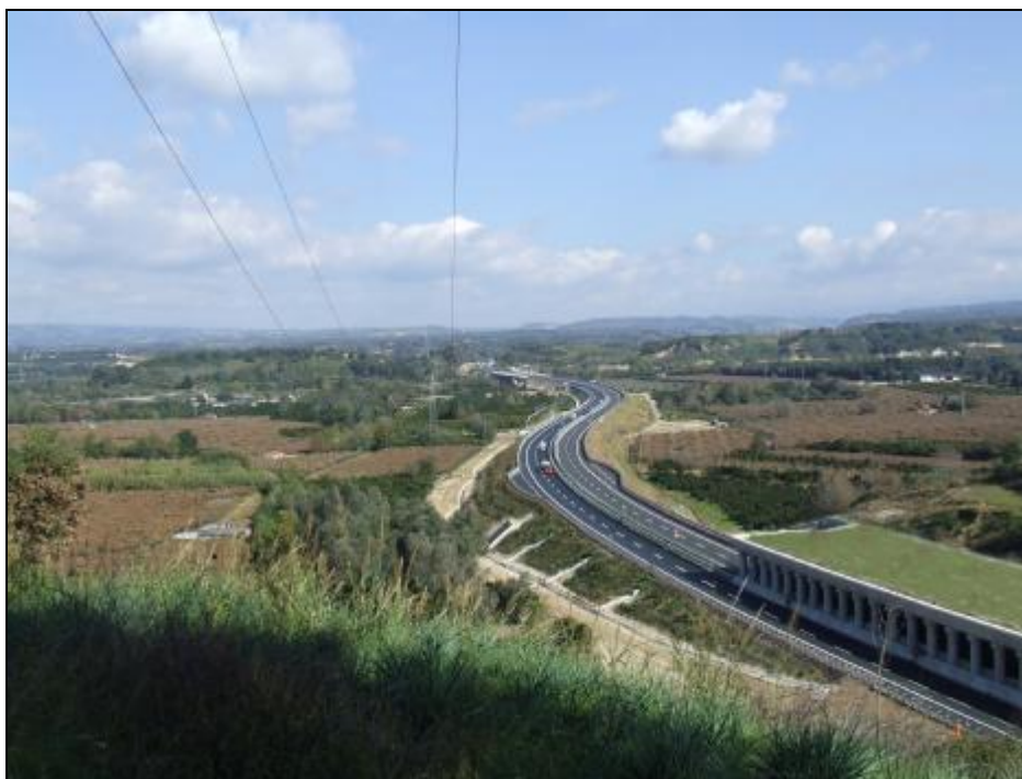
Galleria artificiale di Rosarno Km. 382+500
